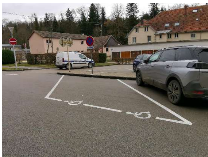
Parking Canissière – Groupe scolaire St Joseph – En état
