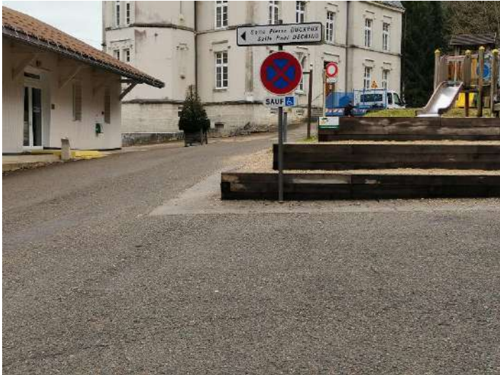
Parking Château du Désert - manque signalisation horizontale
