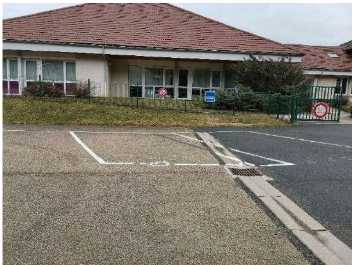
Parking ancienne école maternelle – manque signalisation verticale – nécessité de garder cette place ?
