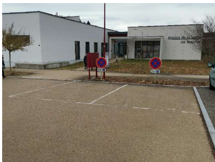
Maison de la santé – rue des Boutons d’Or – 2 places – marquage partiellement effacé
