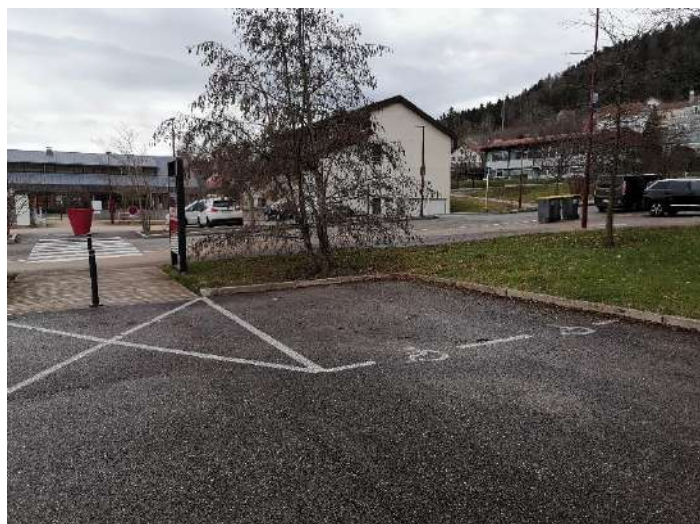
Place de la rasse – rue des Boutons d’Or, haut du parking – absence de signalisation verticale – marquage commence à s’effacer
