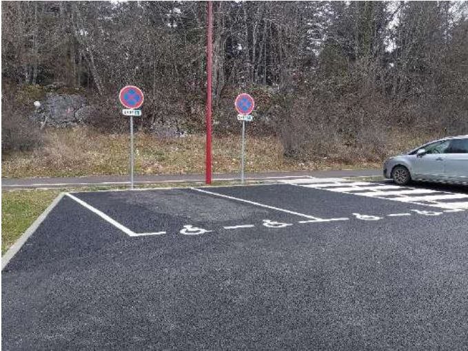
Parking nouveau groupe scolaire - état neuf
